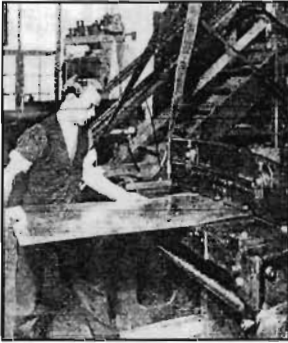
iii) Annealing the Blanks.
